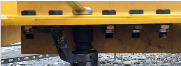
Installation d'écrous ESL à l'aide d'outils manuels
