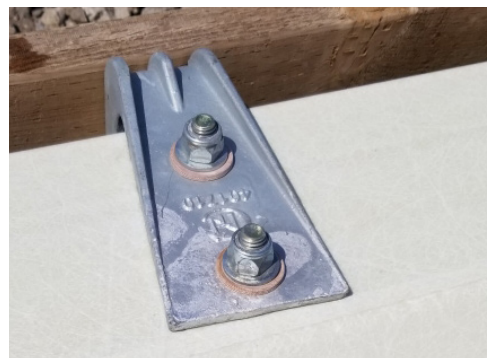
ERM installé sur une planche de recouvrement
